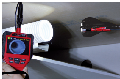
LÜFTUNG- UND WARTUNGS-INSPEKTION
